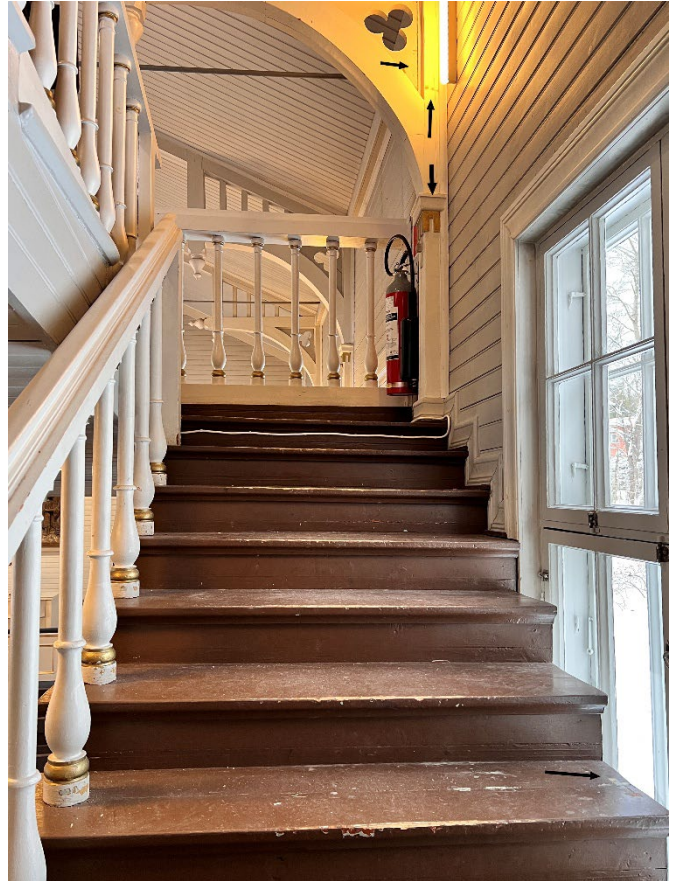
Kuva 3. Avausten paikat. Pilarin avaus on hieman alempana, joten se ei näy kuvassa.
