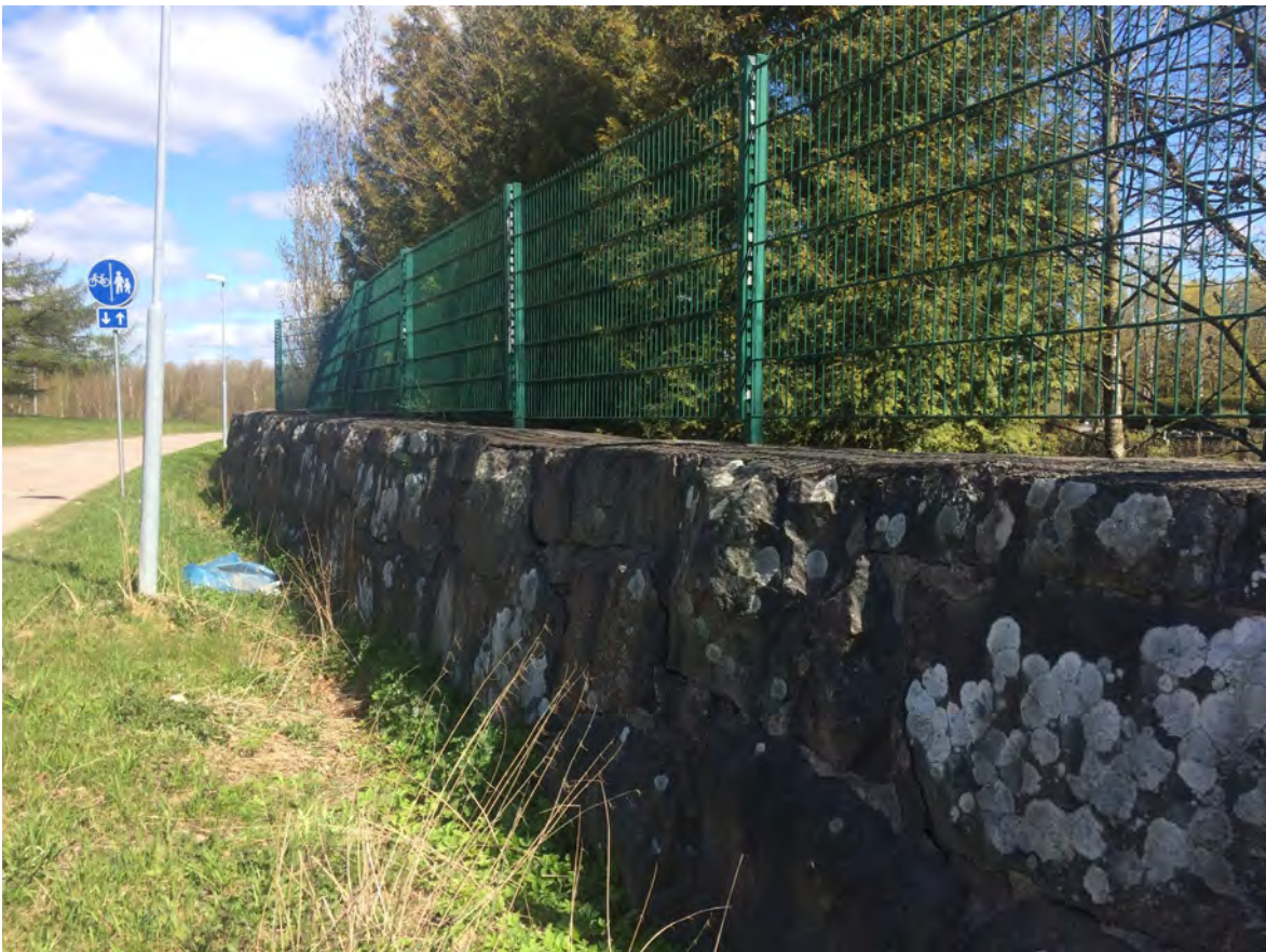
Uuden portin paikka hautausmaan muurin ulkopuolelta.
