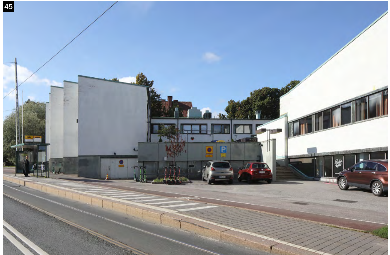
↑ Sisäpiha on nostettu kerroksen verran katutasosta.
