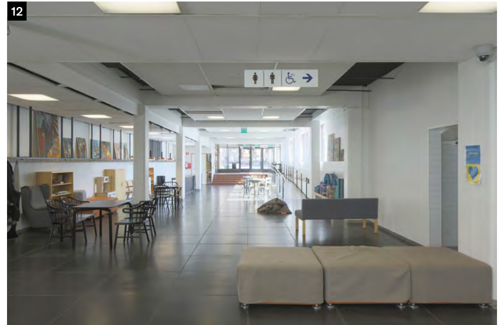
↑ Alahallin pintamateriaalit ovat pääosin alkuperäisiä. Hallissa on uusittu levyalakatto, jossa on hyödynnetty alkuperäisen alakaton teräskannakkeita.
