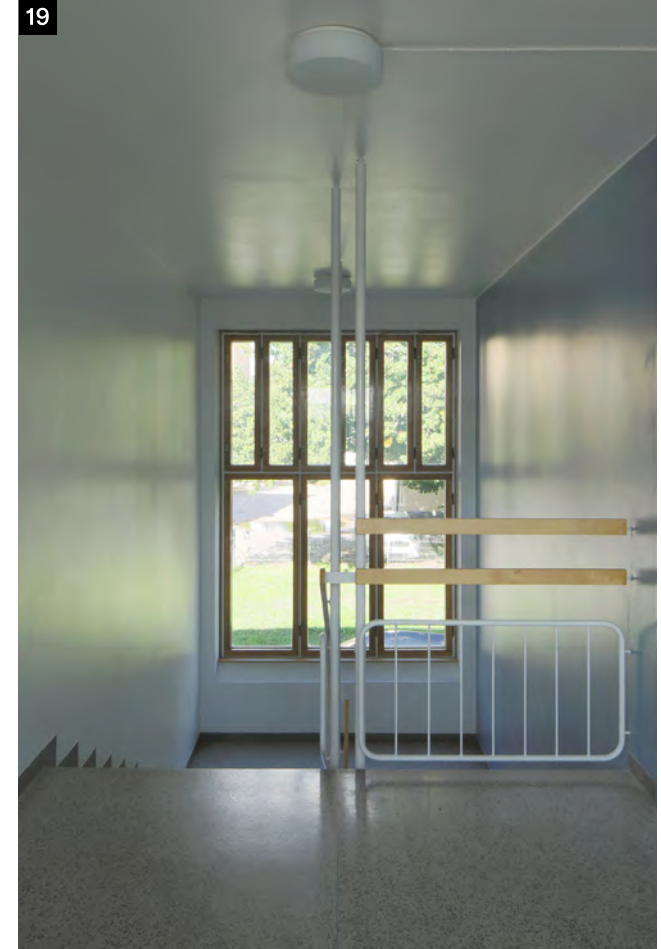
↑ Kerhotila- ja työhuoneosan porrashuone on säilynyt paljolti alkuperäisenä. Porraskaide kattoon saakka jatkuvine tukitolppineen on rakennuksessa toistuvaa tyyppiä.
