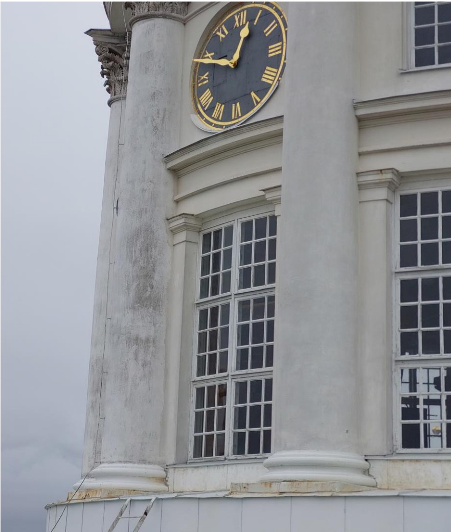
3. Korjausraja kellon vasemmalla puolella 1998 korjatun ja 2009 välillä
