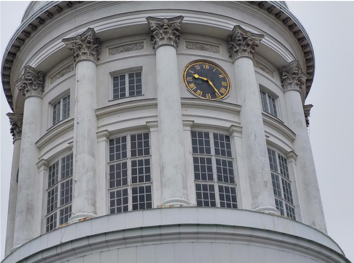
2. Yleiskuva keskustorni kunnosta
