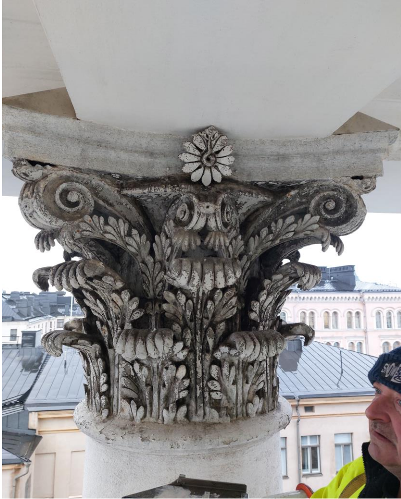
11. Eri kuntoisia pylväiden kapiteeleja
