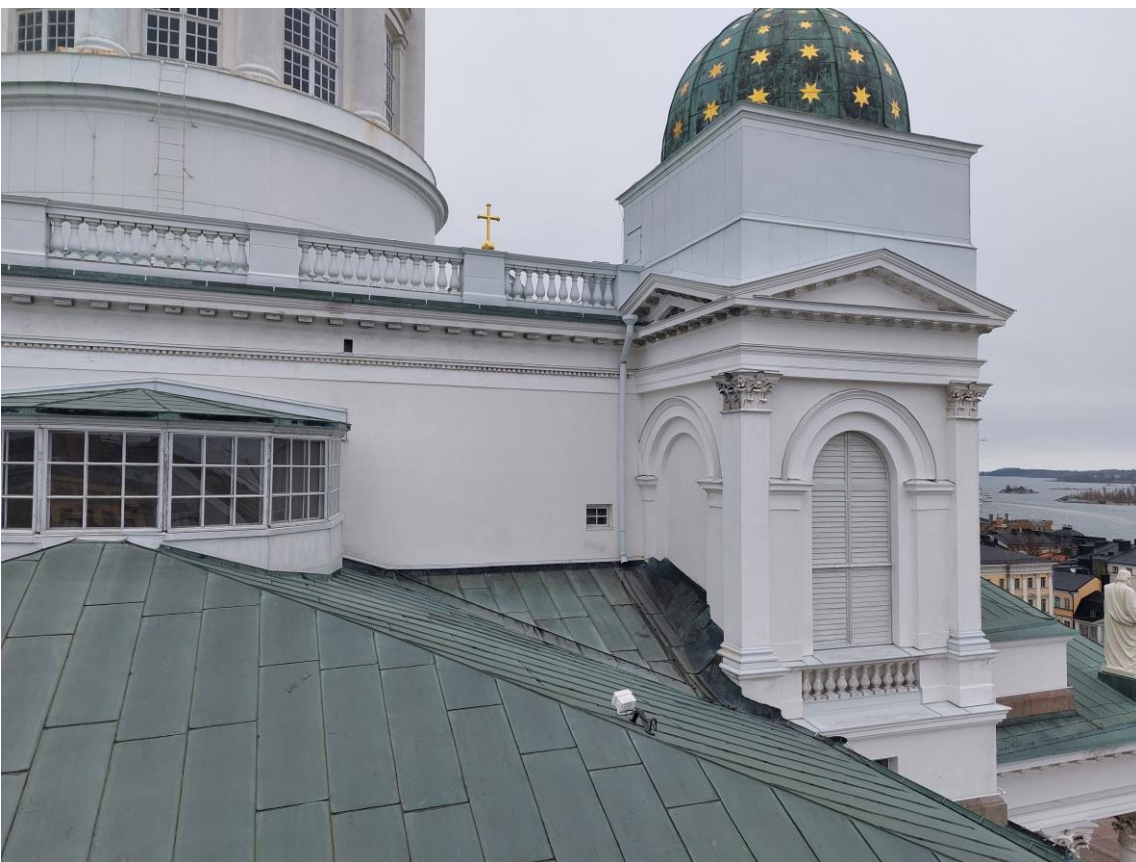
8. Vastaava kohta toisaalla on paremmassa kunnossa
