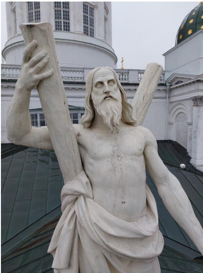
22. Apostolit ovat 25 sitten tehdyn korjauksen jälkeen suhteellisen hyvässä kunnossa
