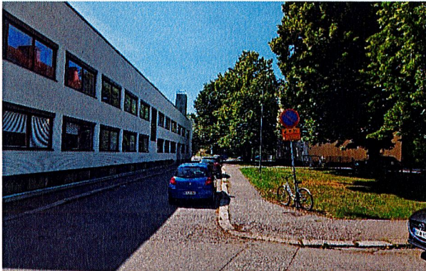
Kuva 2. Hangonkatu Loviisankadun suunnasta
